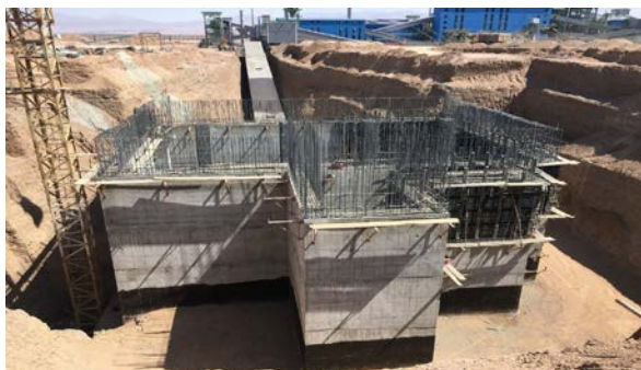
تکمیل بتن ریزی فونداسیون سازه Car Dumper و شروع عملیات ساخت دیوارها
