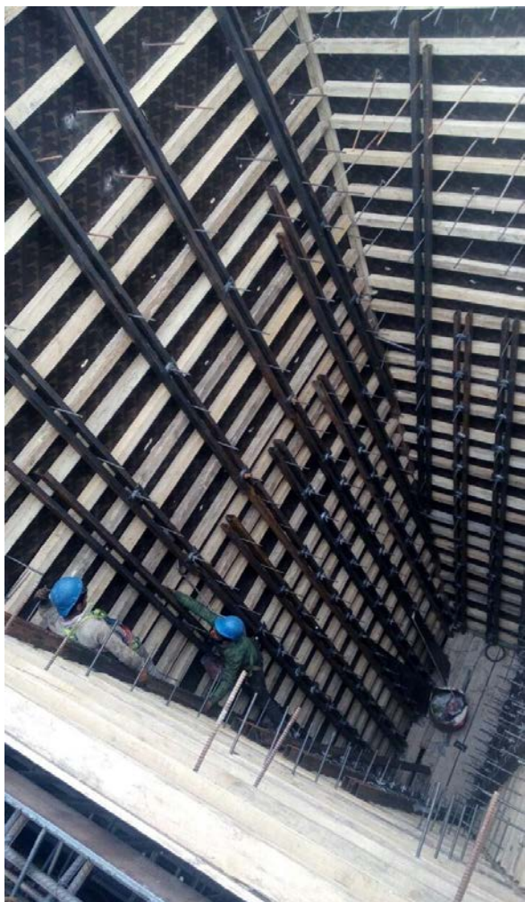
نصب قالبهای داخلی قیف
