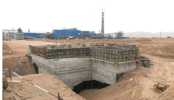
قالب بندی دیوارهای سازه Car Dumper
