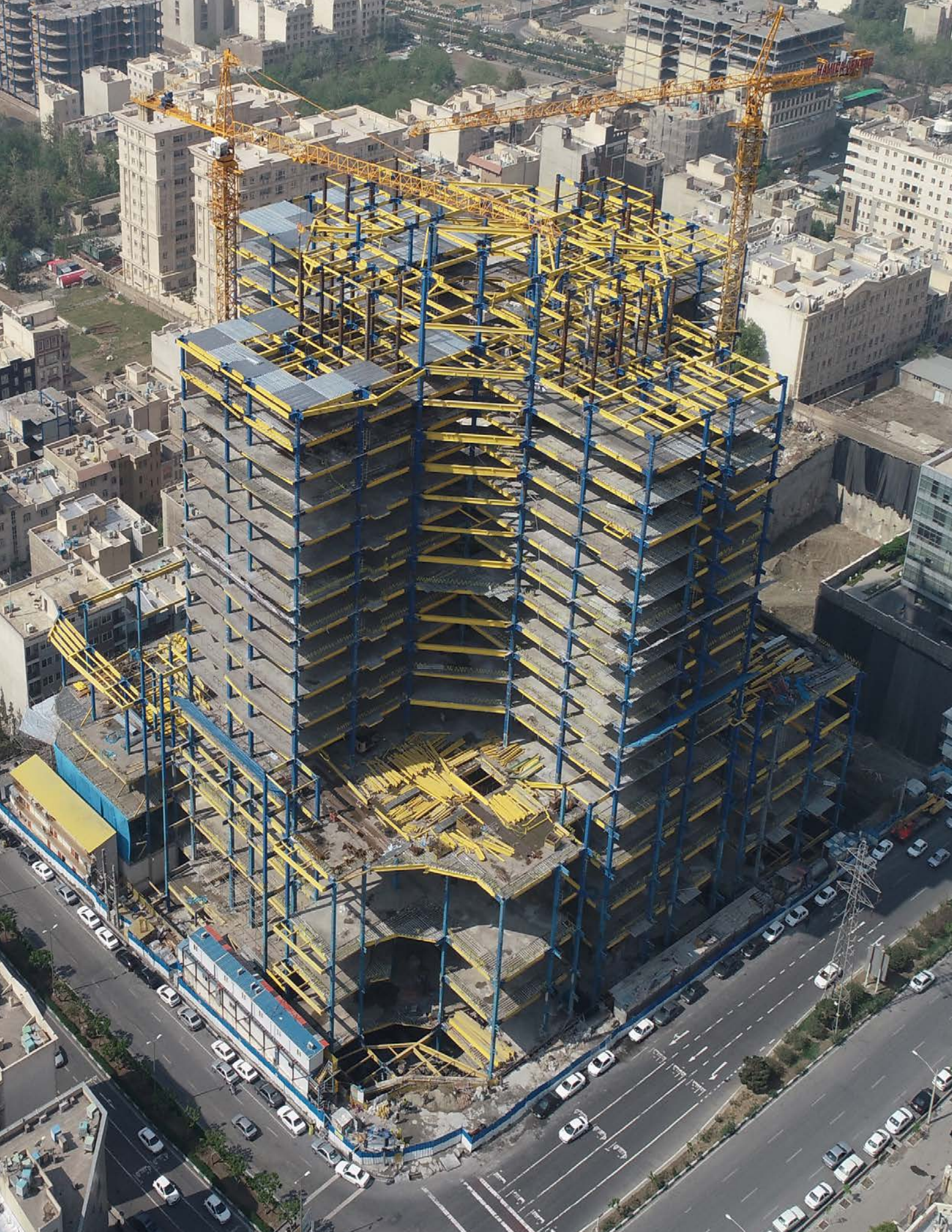
پروژه احداث ساختمانی تجاری اداری همیلا تهران - پونک
