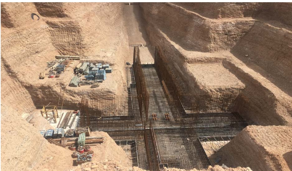
آرما تور بندی فونداسیون سازه Car Dumper
