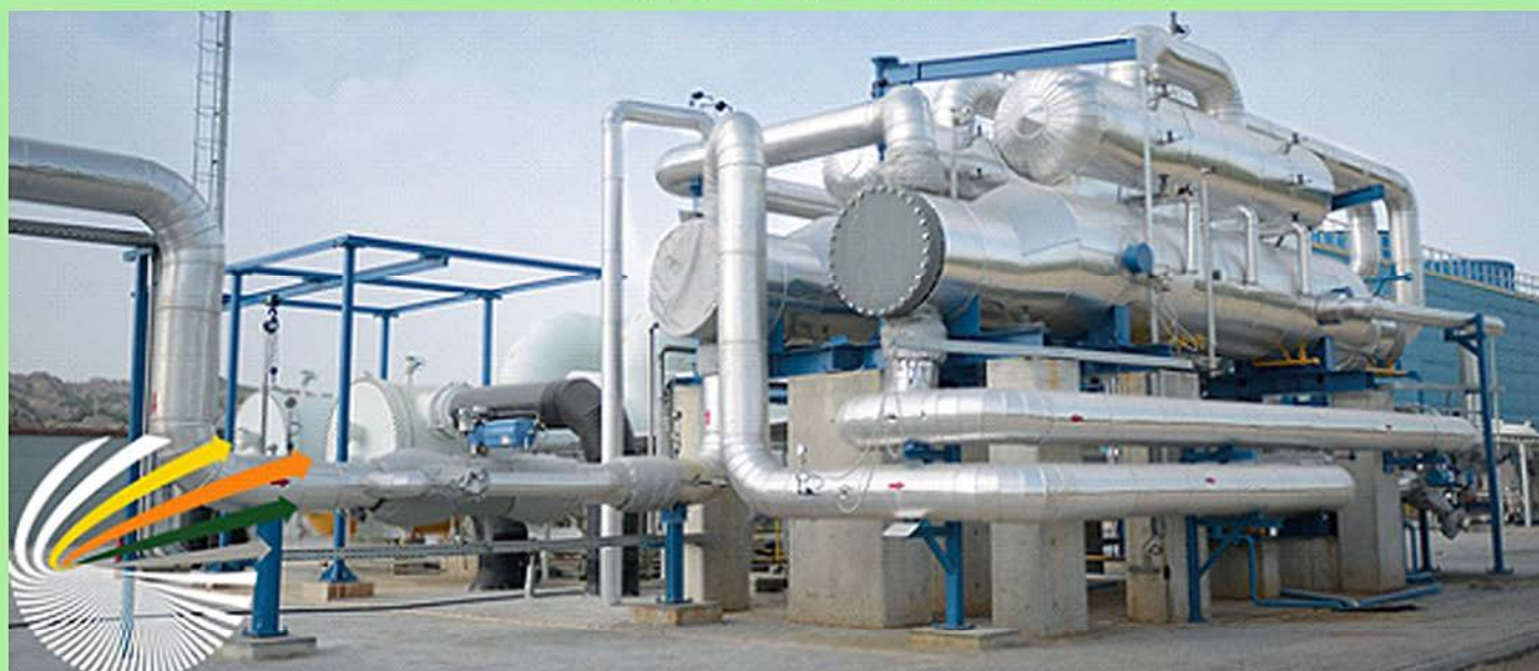
شکل ۴- سیستم ORC برای بازیافت حرارتی گازهای خروجی EAF در کارخانه Acciaierie ایتالیا
