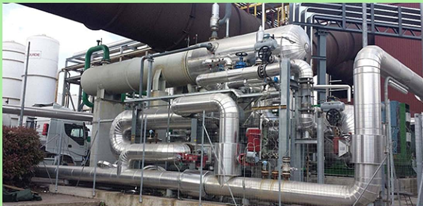
شکل ۴- سیستم ORC برای بازیافت حرارتی گازهای خروجی EAF در کارخانه Acciaierie ایتالیا
