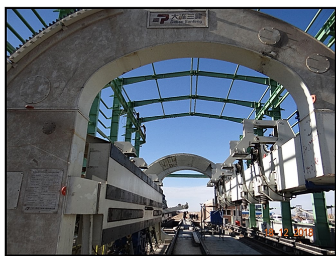
نصب تجهیزات واگن برگردان
