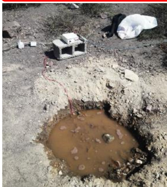
شکل ۳- بستر آندی موقت و سیستم حفاظت کاتدی ایجاد شده برای خطوط لوله دفنی
