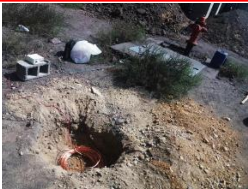
شکل ۳- بستر آندی موقت و سیستم حفاظت کاتدی ایجاد شده برای خطوط لوله دفنی
