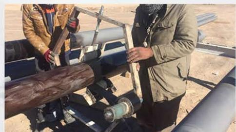
در ضمن ساخت ابزار پیشنهادی توسط هر کسی قابل انجام بوده و به راحتی می توان از متریال ضایعاتی و برون ریز که هزینه اقتصادی بسیار ناچیزی دارد تهیه نمود. برای این منظور نیاز به تعدادی رولیک و قوطی فلزی می باشد تا به صورت عکس رو برو مونتاژ شود.
