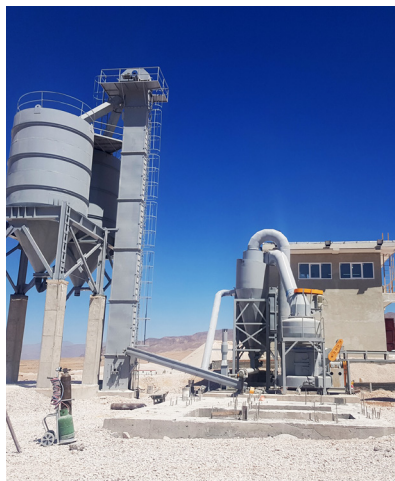
گزارش تصویری از تکمیل پروژه کارخانه آهک میکرونیزه در معدن سرآسیاب
