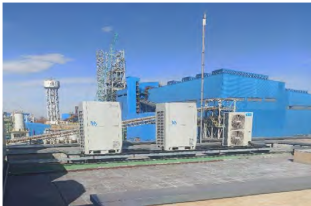
تصویر ۵- سیستم تهویه مطبوع VRV در ساختمان‌های اداری فولاد بوتیا
