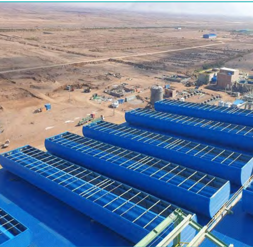
تصویر ۲- هواکش‌های طبیعی سقفی جهت تهویه سالن ذوب (Natural Ventilator)
