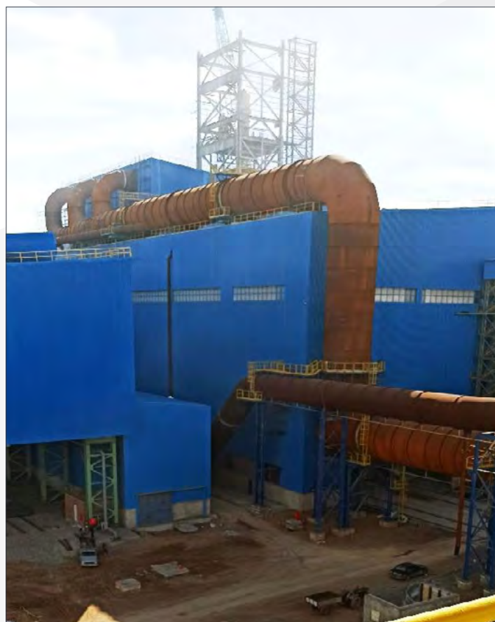
تصویر ۴- ناحیه FDP جهت تصفیه آلودگی‌ها و دمه‌های فلزی و ذرات معلق انتقالی از کوره (تصویر بالا) داکت‌های فلزی FDP جهت انتقال آلودگی‌ها از قسمت فوقانی کوره (تصویر پایین)
