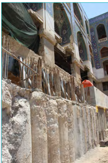
تصویر شماره ۱۰: عملیات حفاری، کیسینگ گذاری و اجرای شمع‌های پیرامون پروژه جهت پایداری گود
